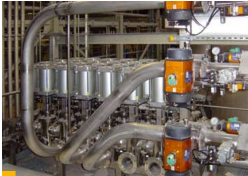
Eingebogene BUTTING Molchleitungsrohre
